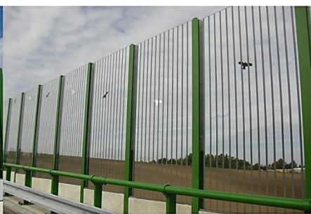
Tatáž stěna po zabezpečení
